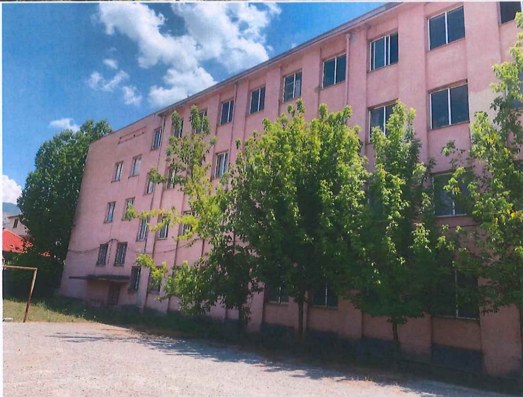
Fasada veriore e objektit, ku është edhe dalja në fushat sportive. Foto brenda shkollës “Demokraciacia”
